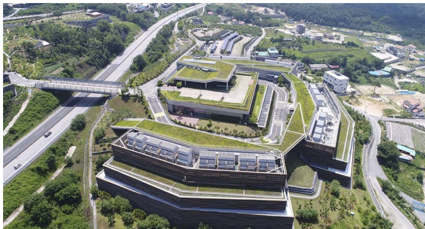
Fig. 3. Naver's data center Kak.
